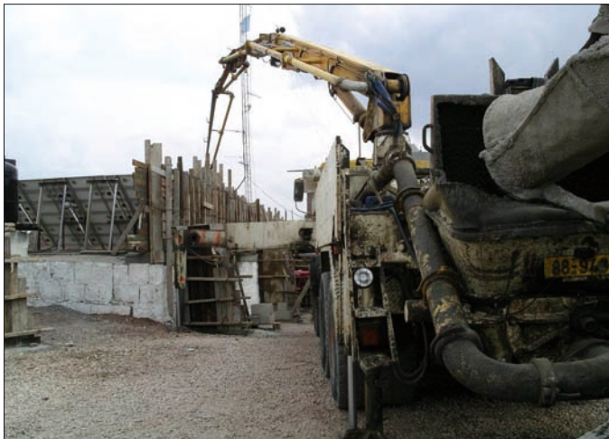
Blast wall construction OP55
